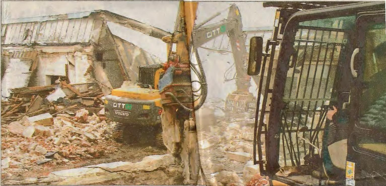
**Abriss und Wiederverwertung:** Der Betonpulverisierer (vorn) der Firma Abbruchtechnik Otto trennt Stahl und Beton der eingerissenen Produktionshallen direkt auf dem Gelände. Das entstandene Material kann später als Unterbaumasse auf dem Areal verwendet werden.
